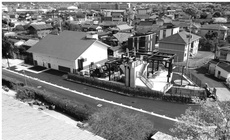
供用を開始した堀内雨水ポンプ場
